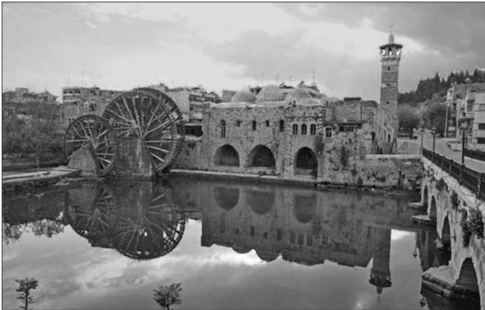
Seyh Ulvân el-Hamevî Köprüsü – Hama
